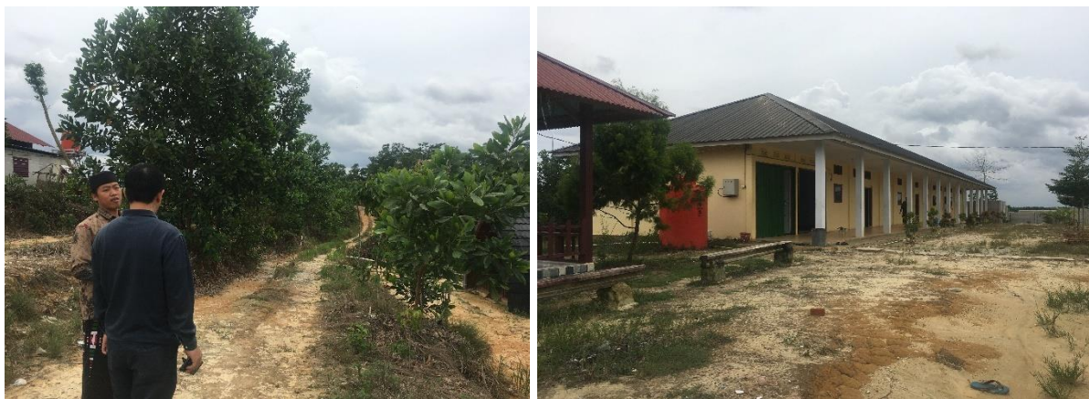
Gambar 3. Kondisi exsisting jalan dan kontur di lahan pesantren dan Kondisi exsisting asrama putra
