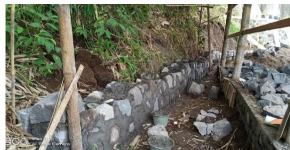
Gambar 6 Proses pembuatan badan dari dinding penahan tebing
