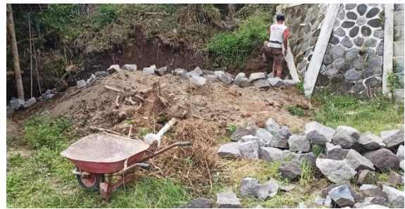
Gambar 5 Pembuatan fondasi kedalaman 0,5 m
