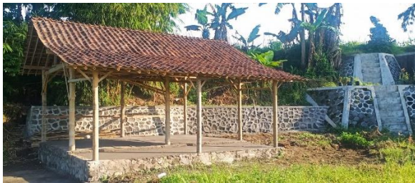
Gambar 7 Dinding penahan tebing yang bersinergi dengan saung ekowisata Sabodam Pabelan
