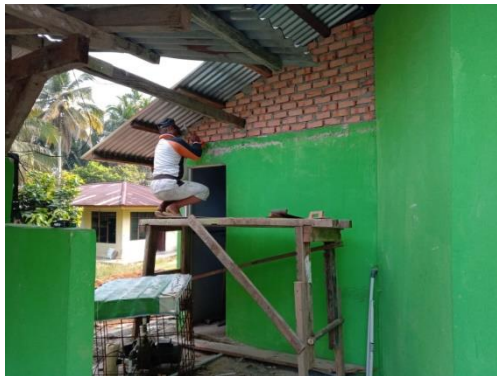
Gambar 7. Persiapan Pemasangan Pintu Kamar Mandi
