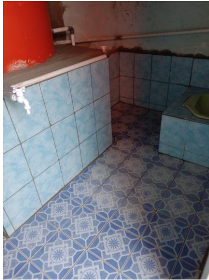
Gambar 4. Kamar Mandi Putra Setelah Direnovasi
