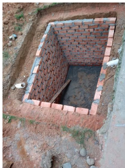
Gambar 1. Lubang Septick Tank Yang Telah Dipasang Bata
